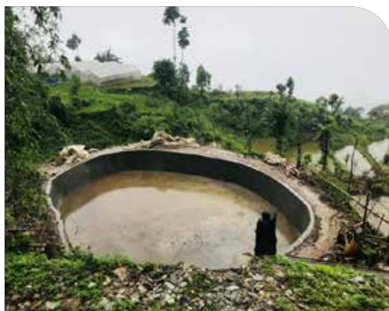
सिंचाई पुर्बाधार निर्माण तथा मर्मत सठभार कार्यक्रम अन्तर्गत निर्माण भएको सिमेन्टेड पोखरी
